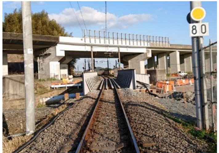
写真-2 工事桁架設完了
