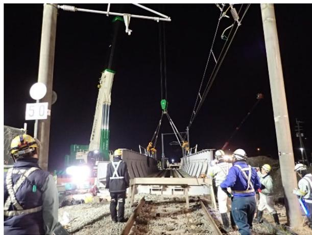
写真-3 工事桁設置状況
