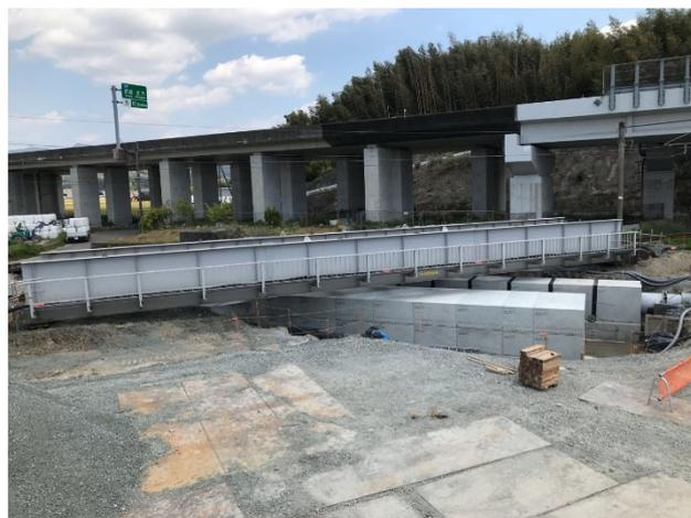
写真-4 ボックスカルバート設置完了
