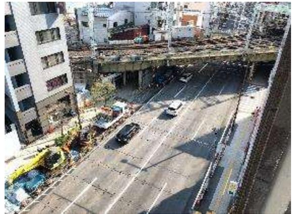
写真-2 路面覆工状況写真
