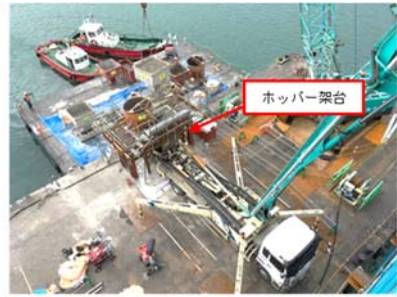
④生コンの打設
