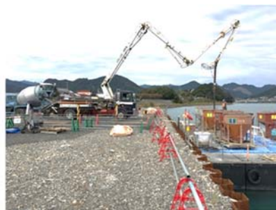
②生コン投入(ホッパー)
