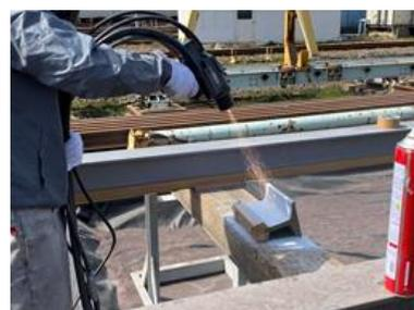
写真-7 アルミ溶射施工
