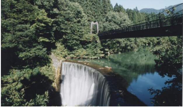
写真 1-1 大源太川第1号砂防堰堤
