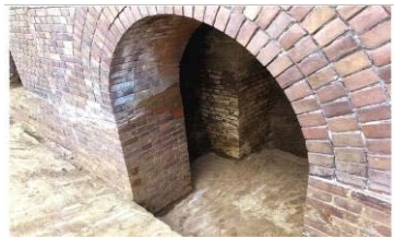
写真-2 煉瓦構造(掩蔽壕)
