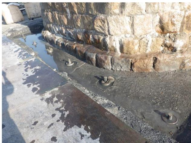
図-5 マイクロパイル工（施工完了）
