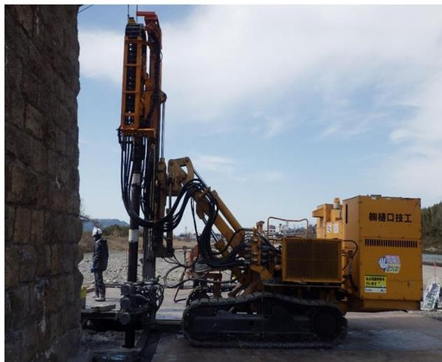
図-4 マイクロパイル工（施工中）
