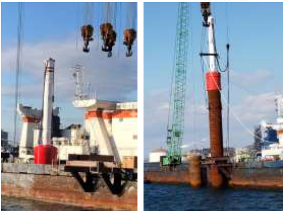
写真-1 油圧ハンマーとテーパー杭の打設状況
