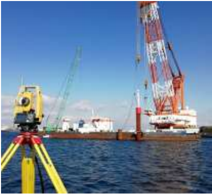
写真-2 「鉛直度」管理状況
