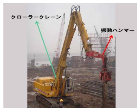
図-8 振動ハンマー杭打ち抜き機
