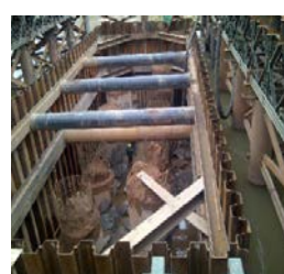
図-5 道路橋の工事
