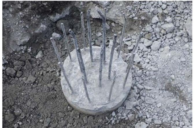
図5 TYPE-II 基礎 斫り出した既設杭
