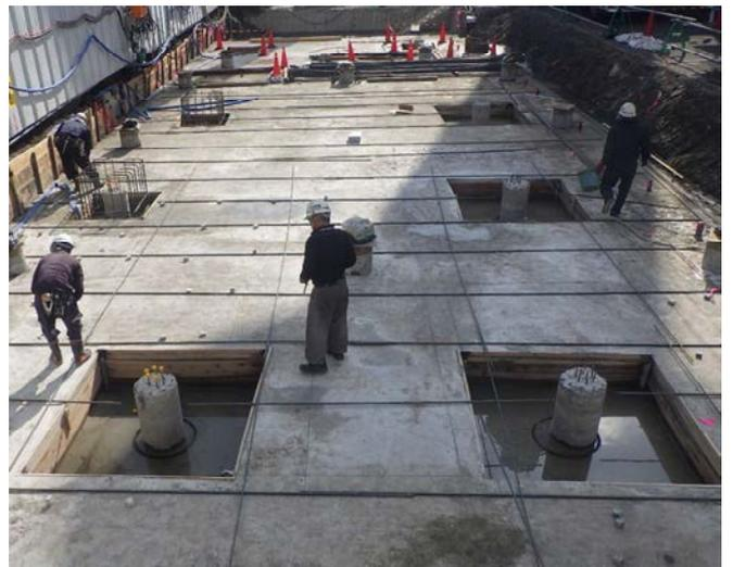
図6 TYPE-II 基礎 均しコンクリート打設後全景
