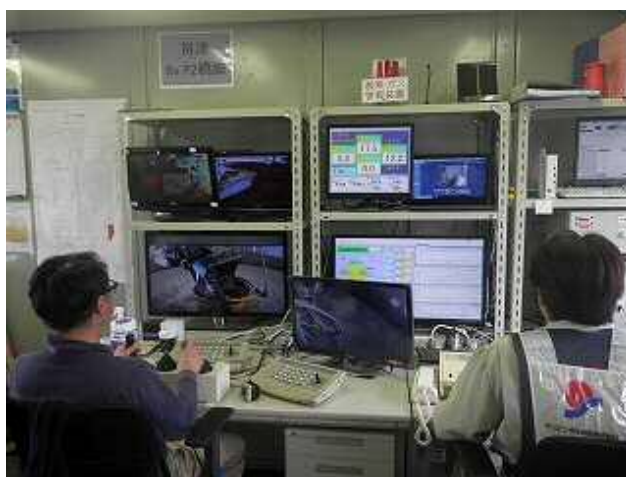
写真-3 遠隔操作による掘削作業
