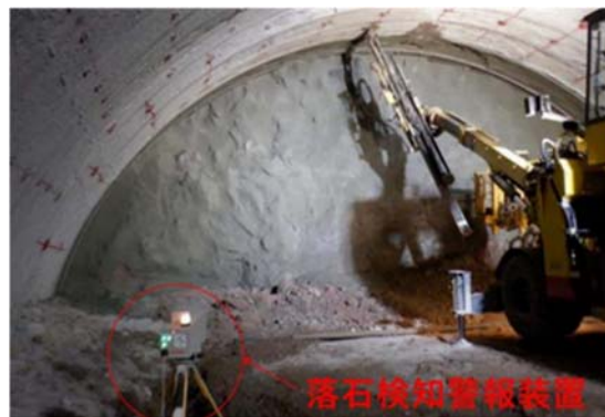
図-3 切羽監視状況
