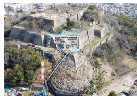
写真-3 令和3年3月時点の現場状況
