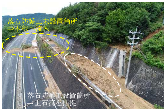
写真-1 土石流の捕捉の様子
