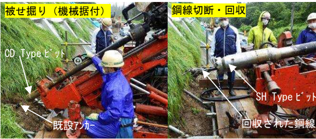
写真-1 試験状況写真 (試験アンカーNo.2)
