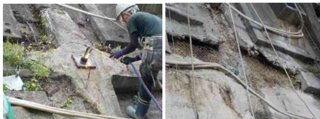
写真1 切断状況(左:切断中 右:受圧板撤去後)
