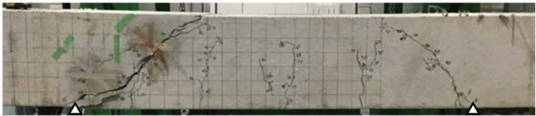
※試験後にクレーンで吊り上げた状態で撮影
