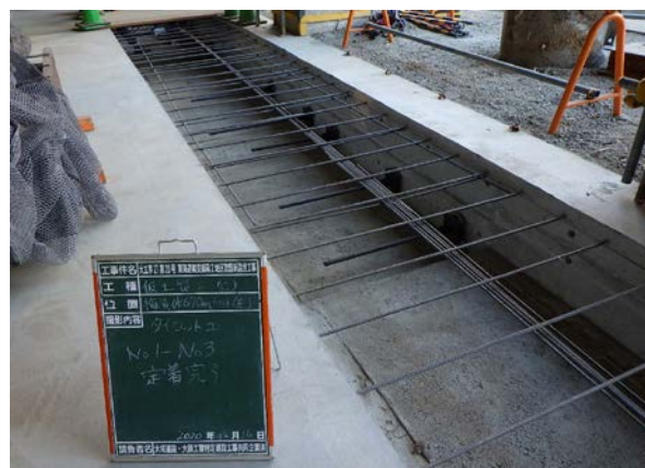
写真 1-1 タイロッドアンカー工法 設置状況
