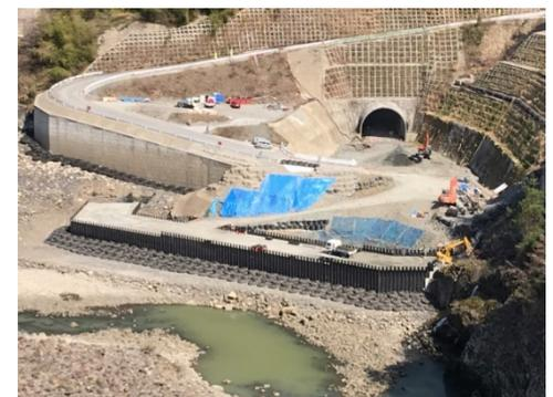
写真-4 ダブルウォール施工状況
