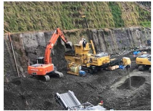
写真-2 INSEM 材製造（移動式土質改良機）
