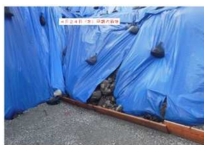
岩盤の一部挙動確認
