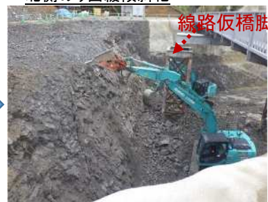
北側のり面緩傾斜化
