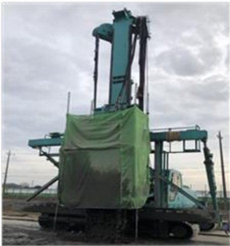
写真 1 TRD 工法
