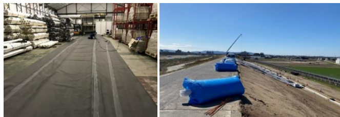
図-3 左：工場での広幅加工，右：梱包搬入状況
