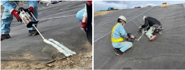
図-7 専用接着剤による貼り合わせ状況
