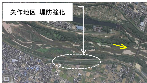
図-1 令和2年度 矢作川渡堤防補強工事位置
