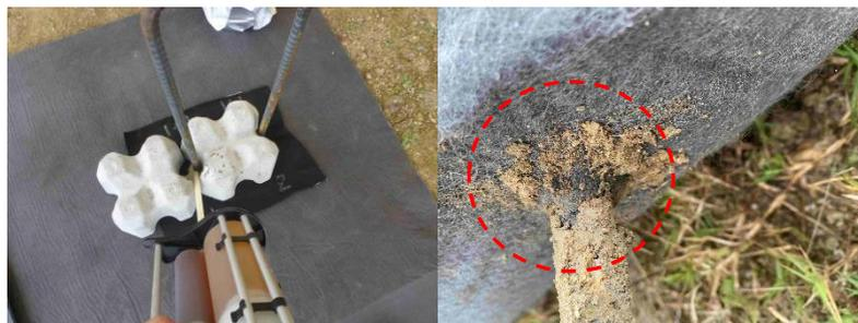
図-5 左:接着剤塗布状況, 右:接着剤含浸硬化状況
