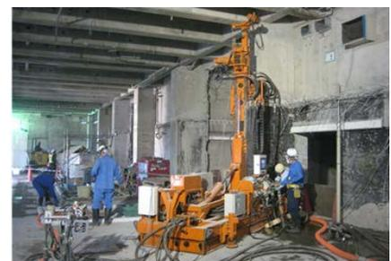
図-2 小型施工機による施工
