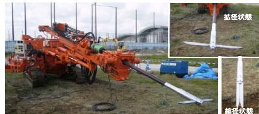
図-1 標準施工機及び攪拌翼
