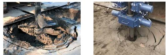
(a) 固定式攪拌翼 (b) 拡翼型攪拌翼
