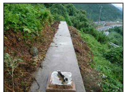
写真-1 鋼管杭の頭部連結コンクリート
