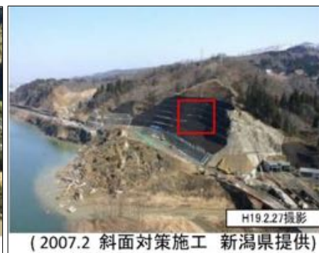
写真.2 斜面对策施工時
