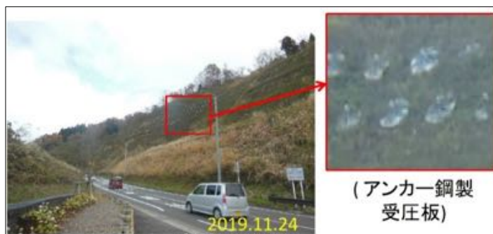
写真.3 災害から 15 年後の斜面復旧状況
