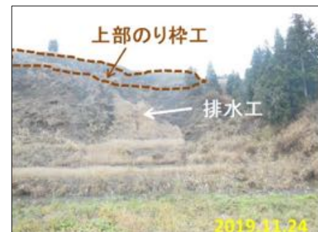
写真. 6 15年後の斜面復旧状況
