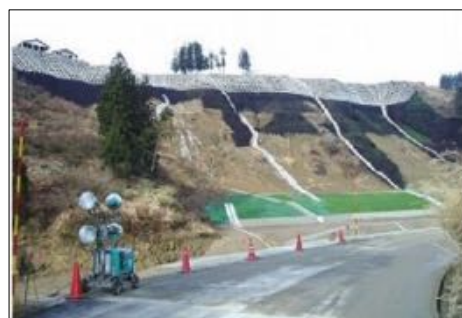
写真. 5 復旧対策施工時(新潟県)
