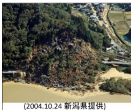
写真.1 被災時の斜面崩壊
