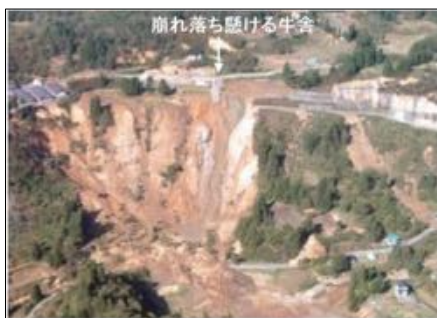
写真. 4 被災時の斜面崩壊(新潟県)
