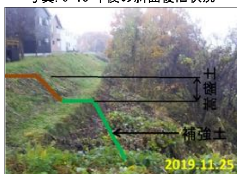
写真. 8 15年後の斜面復旧状況
