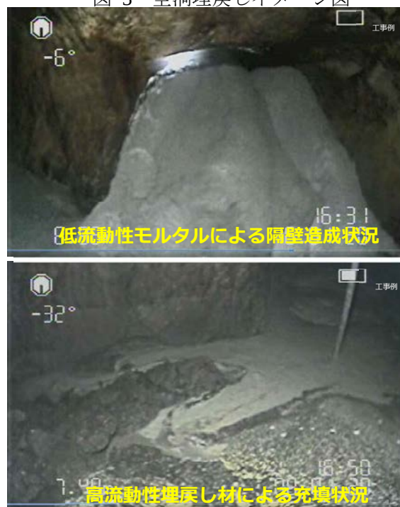
写真-2 埋戻し状況(B地区)
