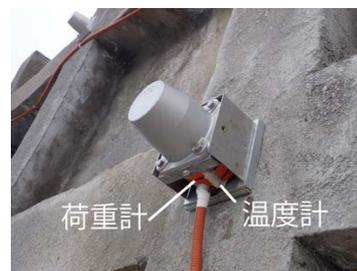
写真2 荷重計設置状況
