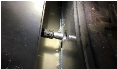
写真-1 HGA 継手挿入状況
