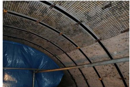
図1 バサルト帯板補修工
