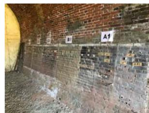
写真-② 塗布材試験施工
