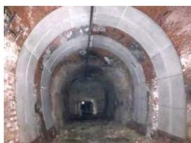
写真-④ パネル材設置
