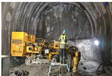
写真-1 前方地質探査 (PS ワイヤライン工法)
