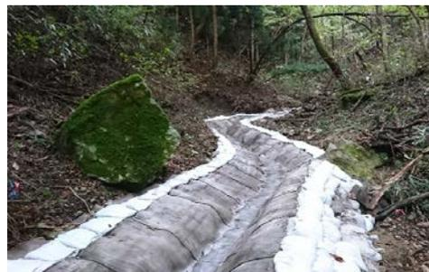
写真-3 地表面沢水対策工 (コンクリートキャンパス工法)
