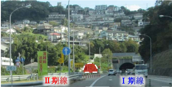
写真 1 西側坑口現況
