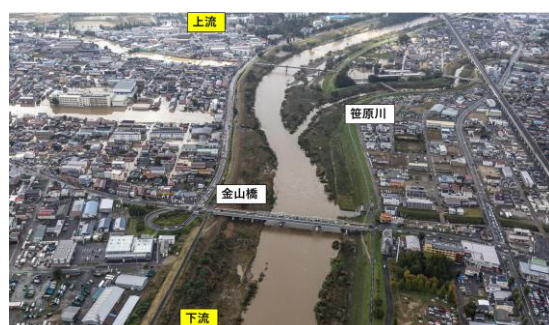
図5 台風19号時金山橋航空写真(2019年10月14日撮影)
