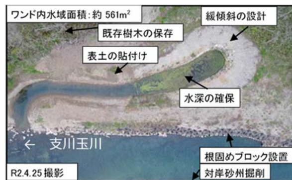
図-2 新設ワンド整備後の状況
