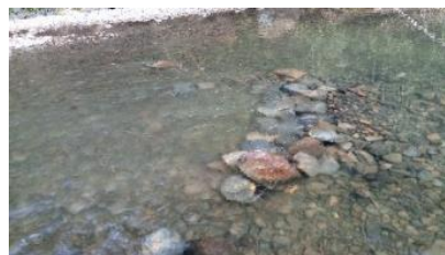
写真1 武茂川に設置された部分的な石組みの状態
