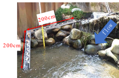
写真-4 魚道設置状況（魚道設置後）
