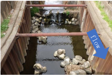
写真-1 H 橋落差工
