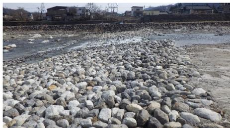
写真4 1/8 勾配の粗礫斜路の流況 (大武川第 49 号床固工)
