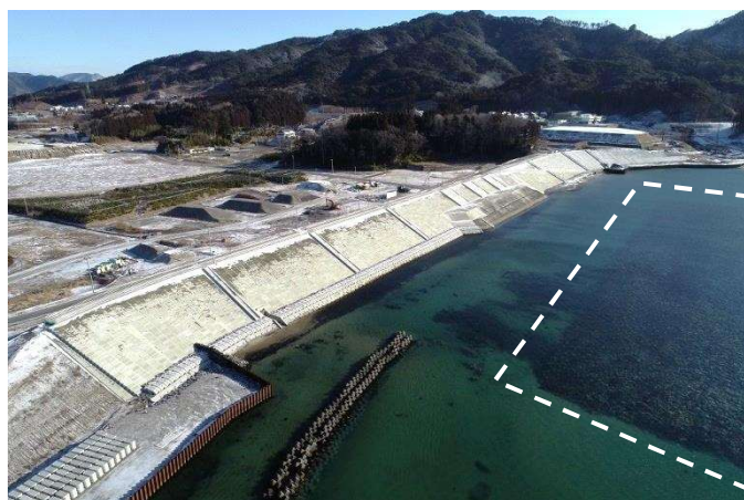
写真-1 調査対象とした人工リーフの全景写真
