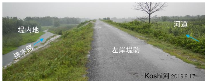
図-1 Koshi 河では河床が堤内地よりも高くなっている
