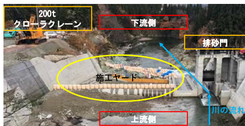
写真-2 施工ヤード全景
