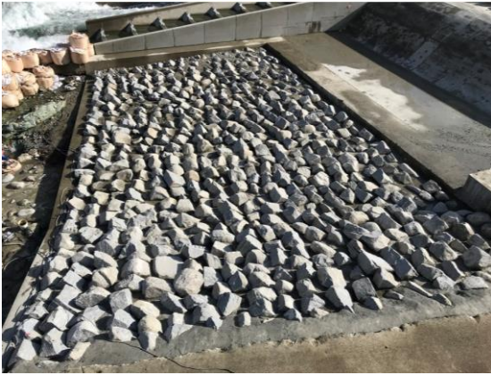
写真-7 石組み完了後全景
