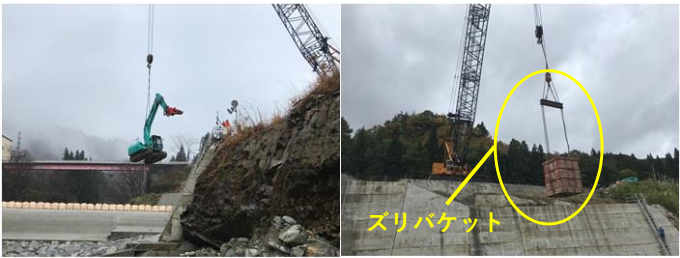
写真-3 バックホウ吊下げ
