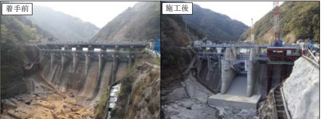
写真 1. 改造工事着手前及び施工後比較
