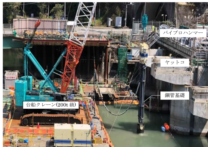
写真 3. 台船クレーンによる鋼管基礎引抜
