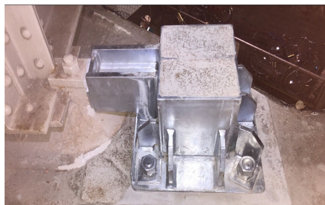
写真1 移動制限装置設置完了
