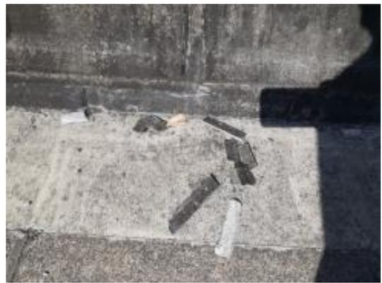
写真-2 目地モルタルの剥落
