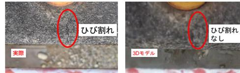
図-7 実ひび割れと 3D モデル上のひび割れ
