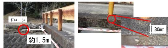
図-5 橋梁ひび割れ確認
