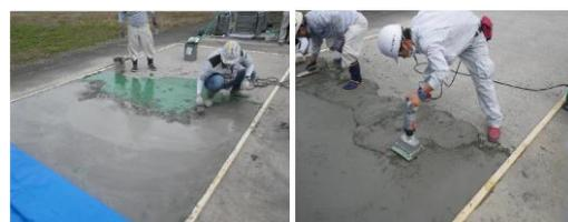
図3 高強度モルタル打設状況
