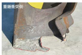
写真-1 実験終了後の損傷状況 ( H = 2\text{m} )
