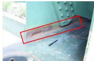
写真-1 格点部の腐食例
