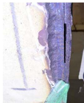
写真-1 すみ肉溶接部の腐食切れの一例
