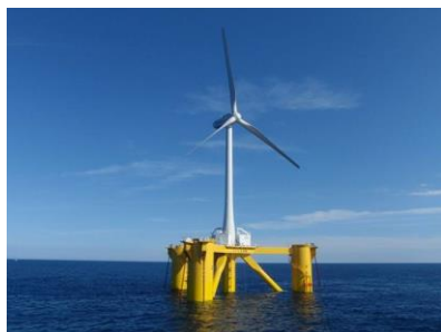
図1 福島沖 2MW 風車搭載セミサブ浮体
